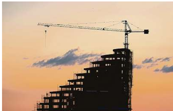
Výstavba nového bytového domu v albánské Tiraně. Právě v této zemi Češi stále více kupují nemovitosti.
